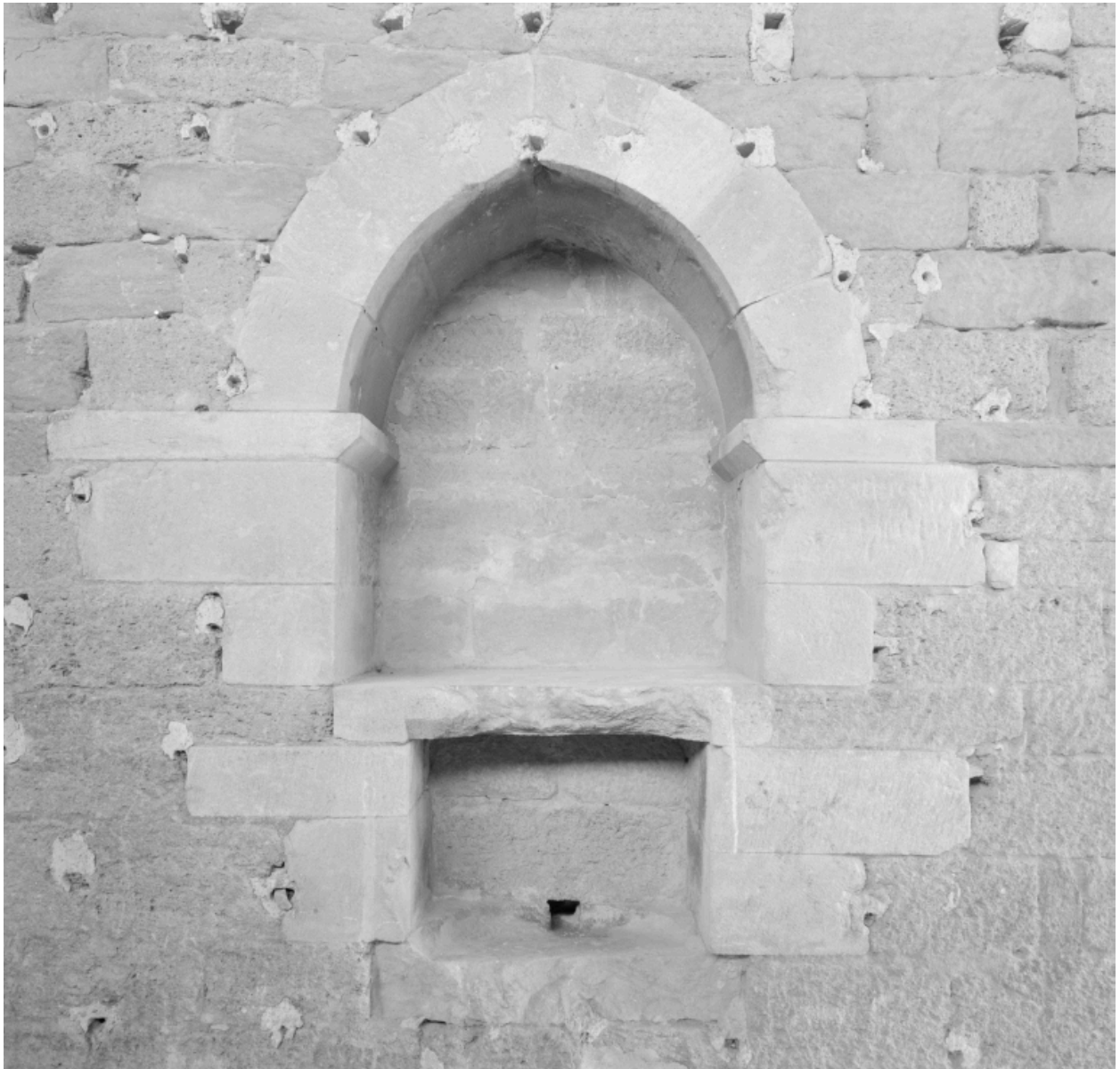
Mur nord, vestiges d'un évier roman.
