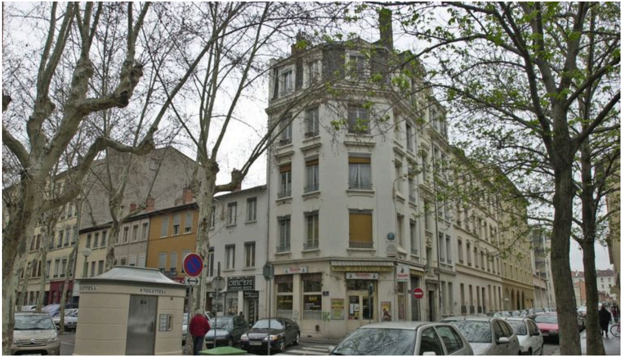
Façades sur rue et angle de l'immeuble vus depuis le sud-ouest
