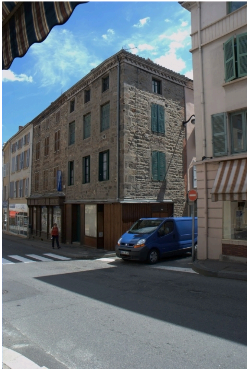
Îlot 8. Clermont (rue de) 66 / Carnot (place). Vue générale des façades sur la rue et la place.
