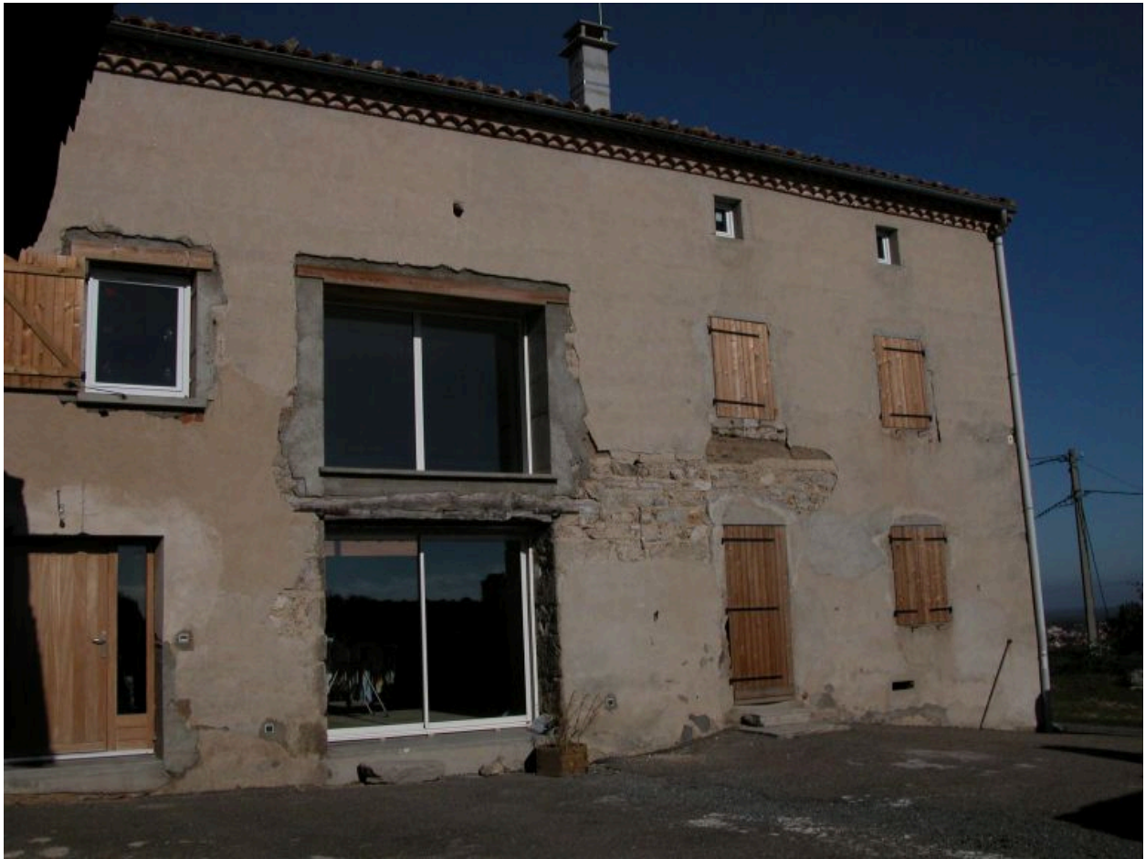
Vue d'ensemble de la façade du logis.
