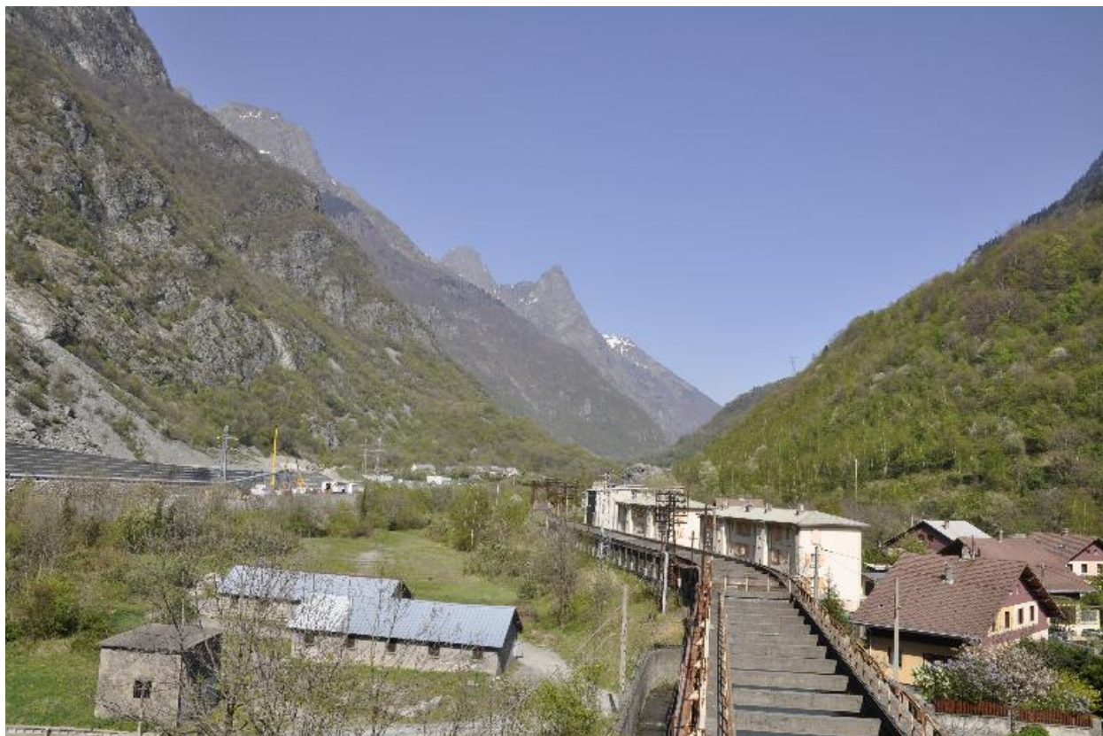
Vue du canal
