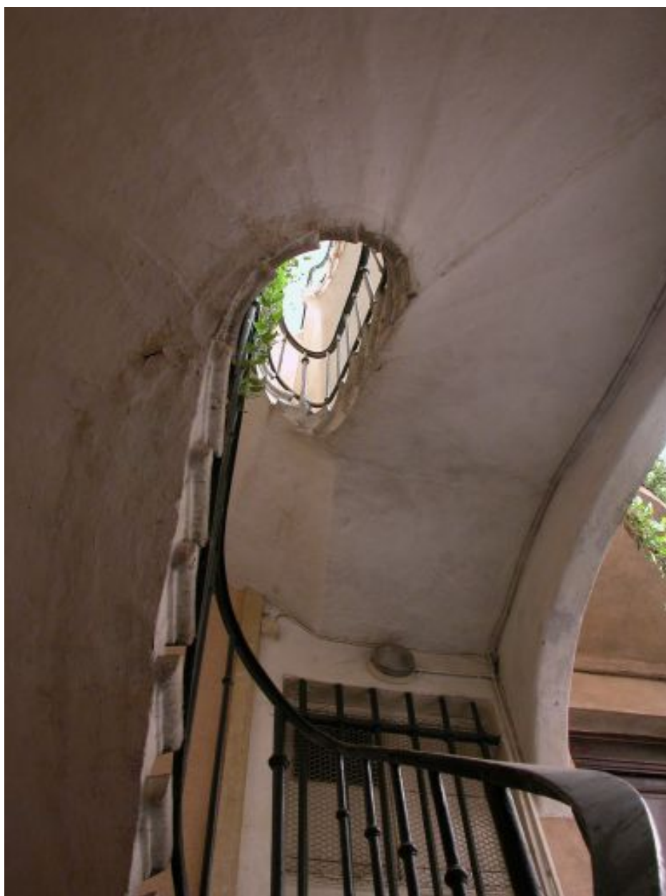
Vue par-dessous du 3e étage d'escalier
