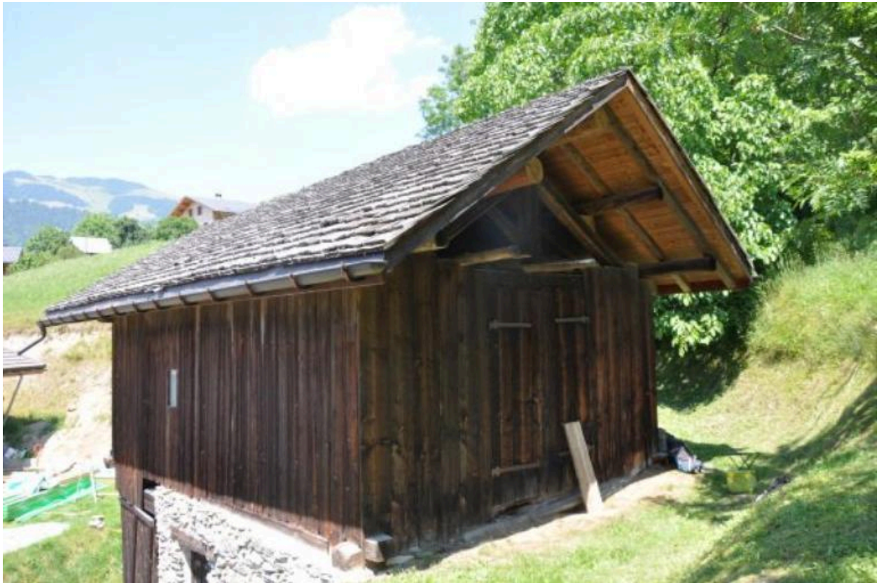
Vue de l'ancien pressoir.
