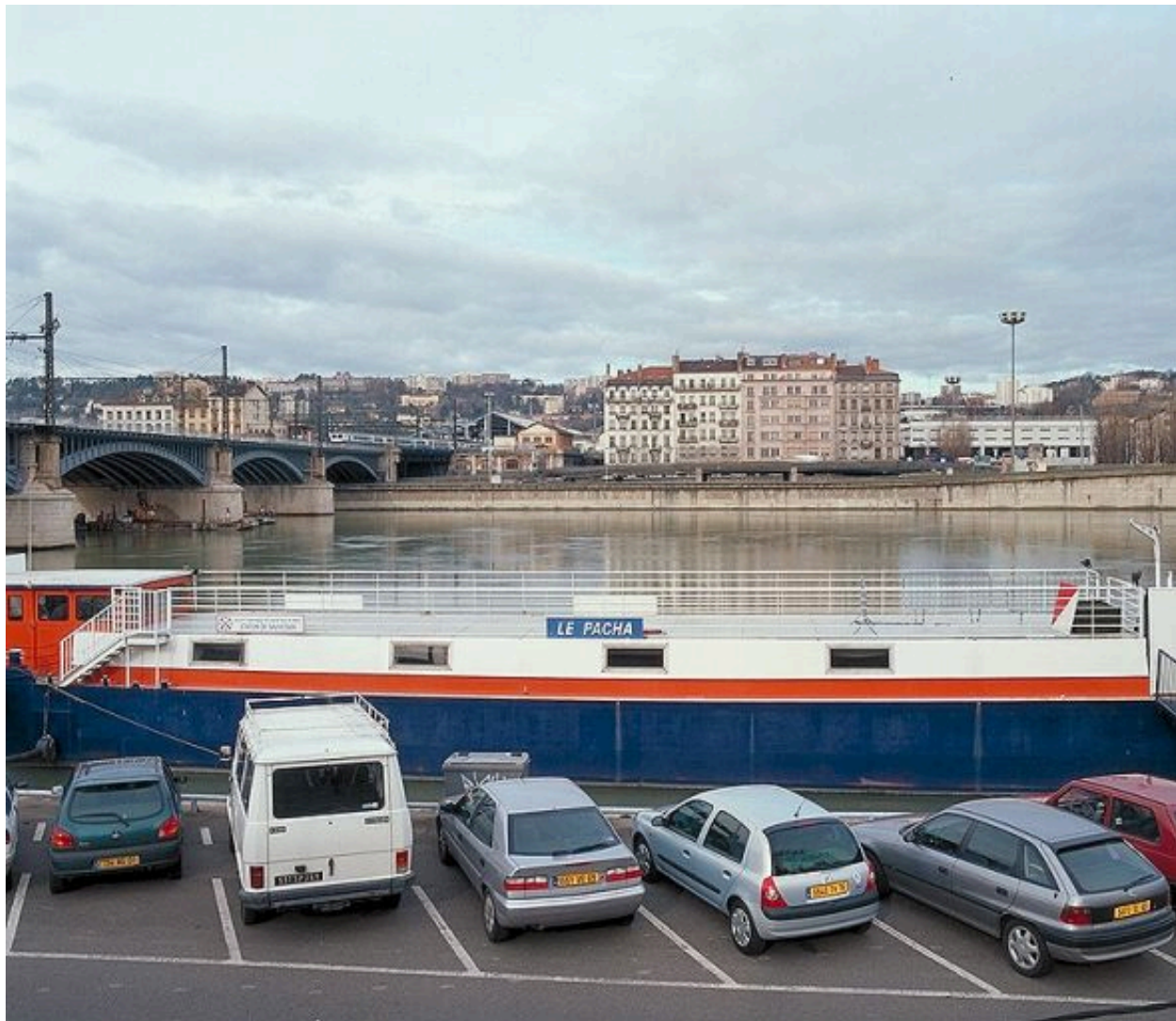
Vue d'ensemble du pont depuis le nord-est
