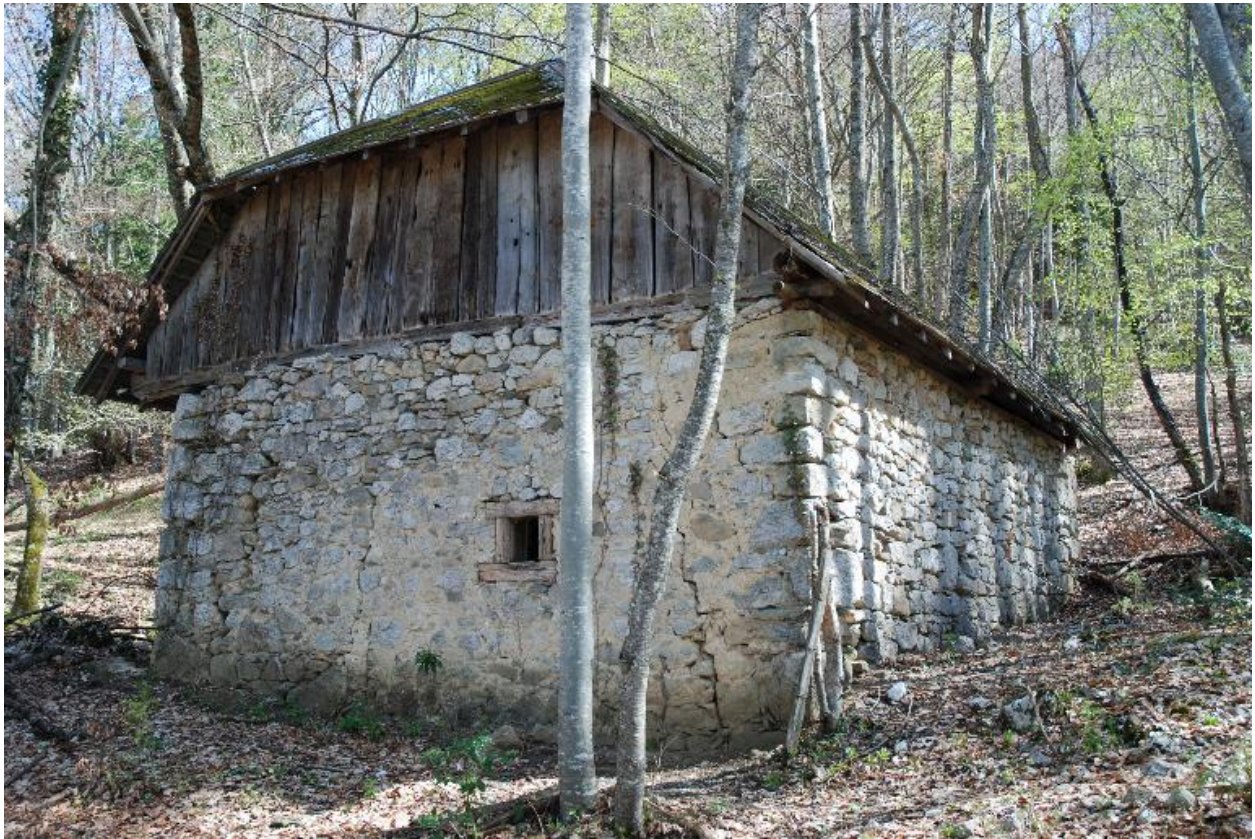
Vue du mur pignon aval.
