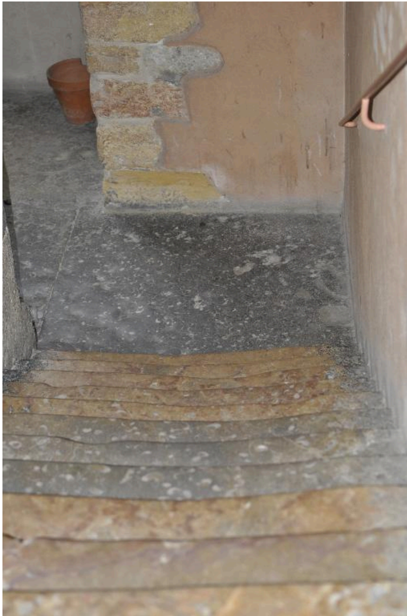
Détail d'un palier intermédiaire et des marches de l'escalier du n°12 rue Dumenge
