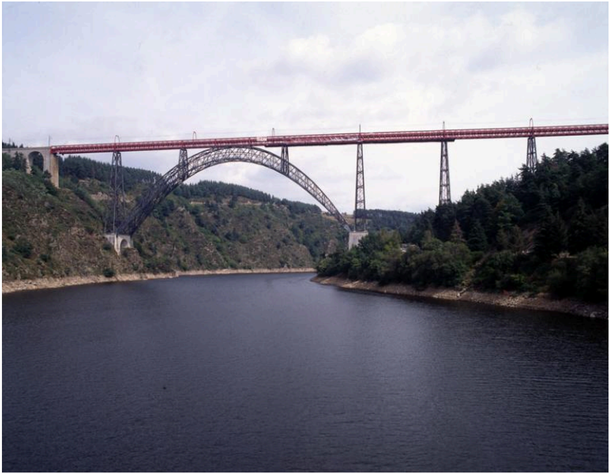
Vue de trois quarts du viaduc depuis les rives de la Truyère.
