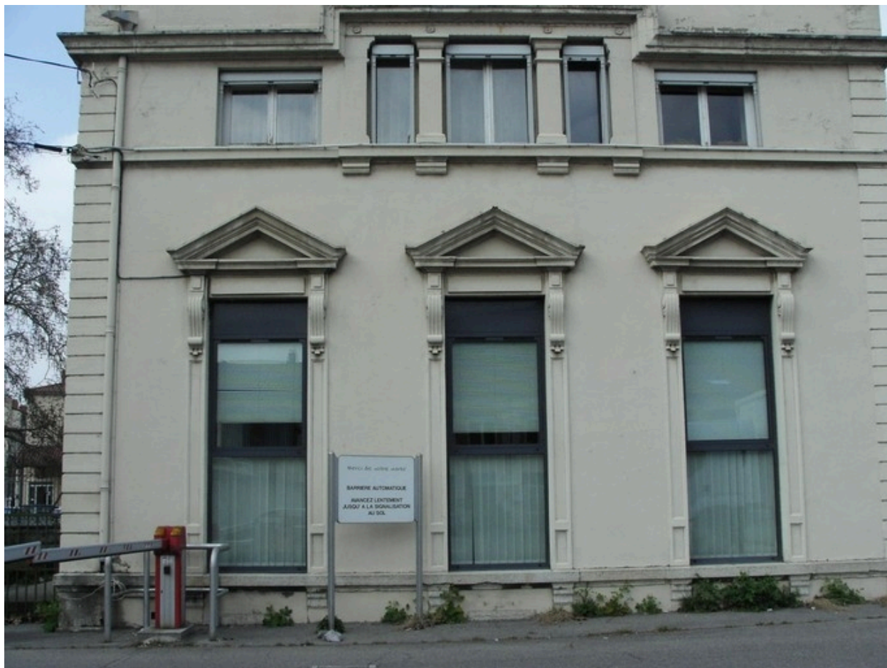
façade sud des bureaux
