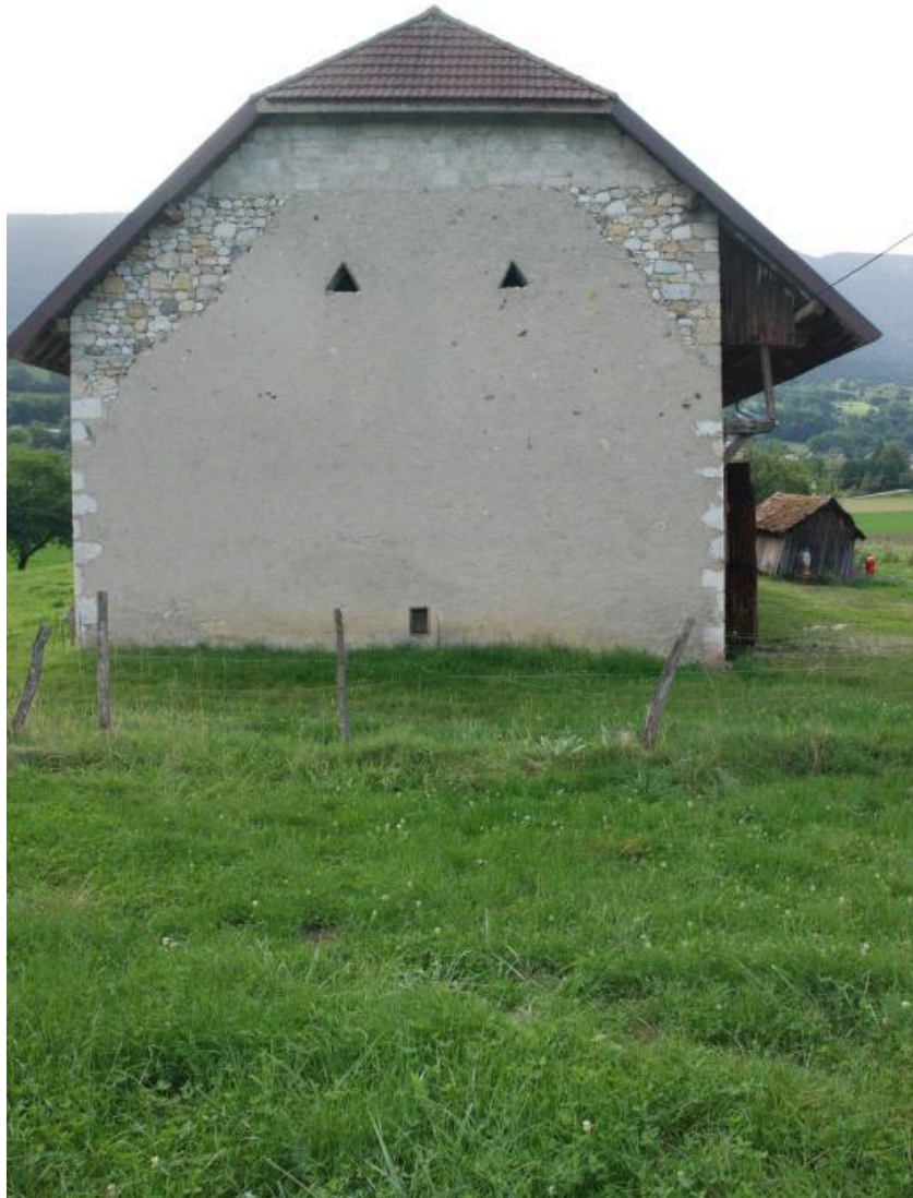
Vue d'ensemble du mur pignon ouest des grange-étables
