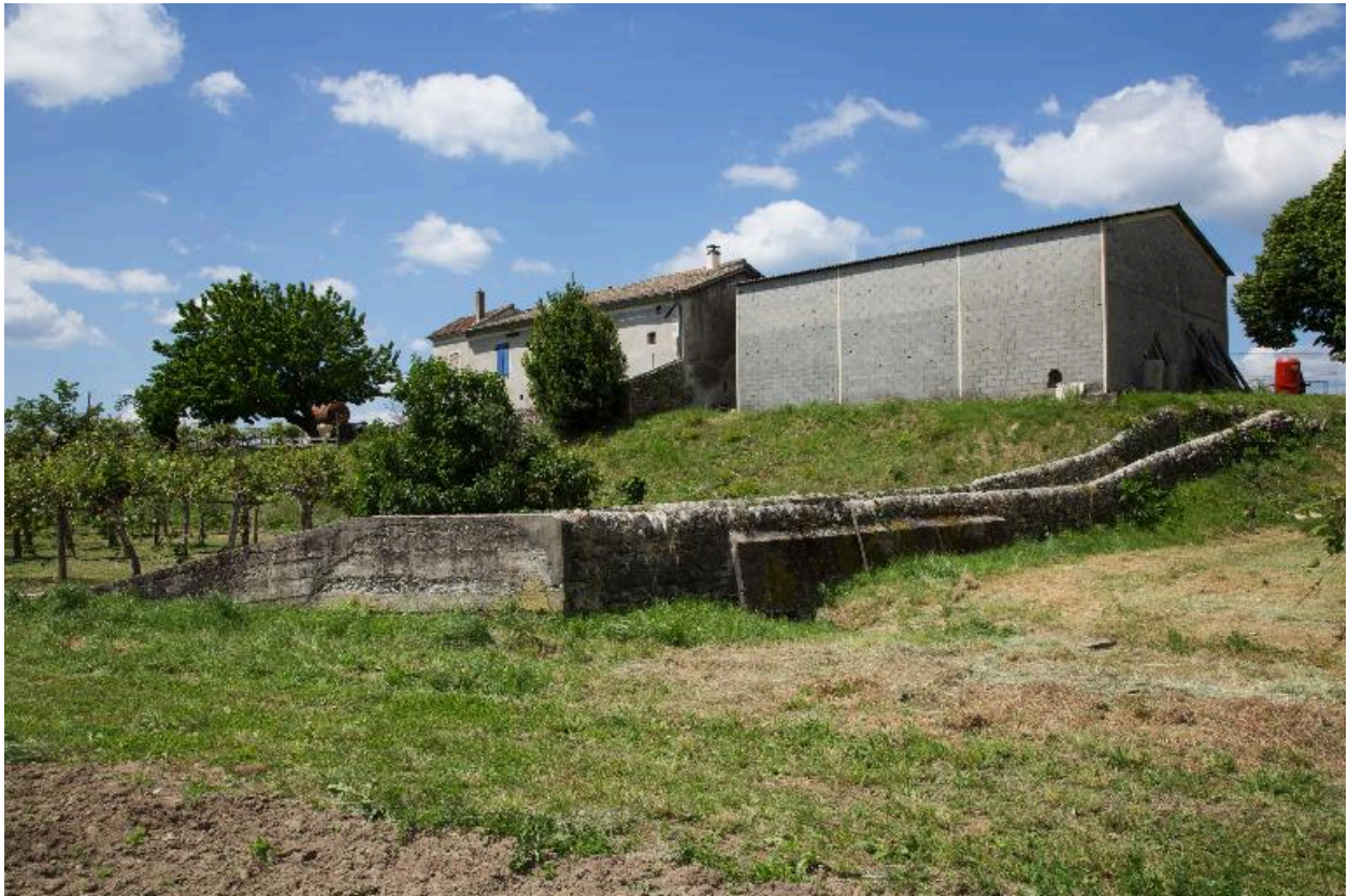
Vue générale depuis l'ouest, canal maçonné au premier plan
