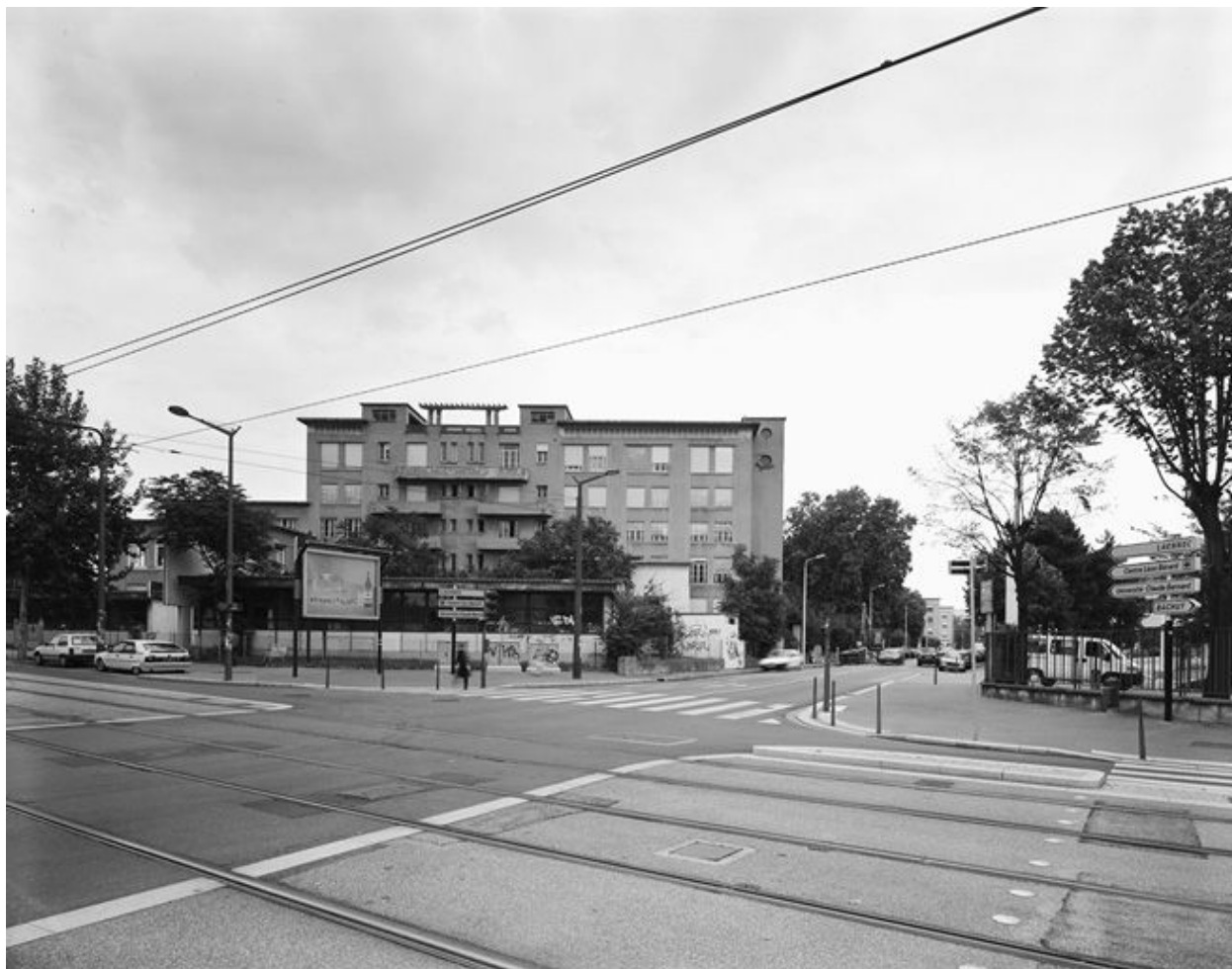
Vue générale du côté ouest
