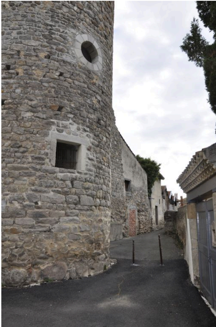
1986 AE, rue de la Tour depuis le nord.
