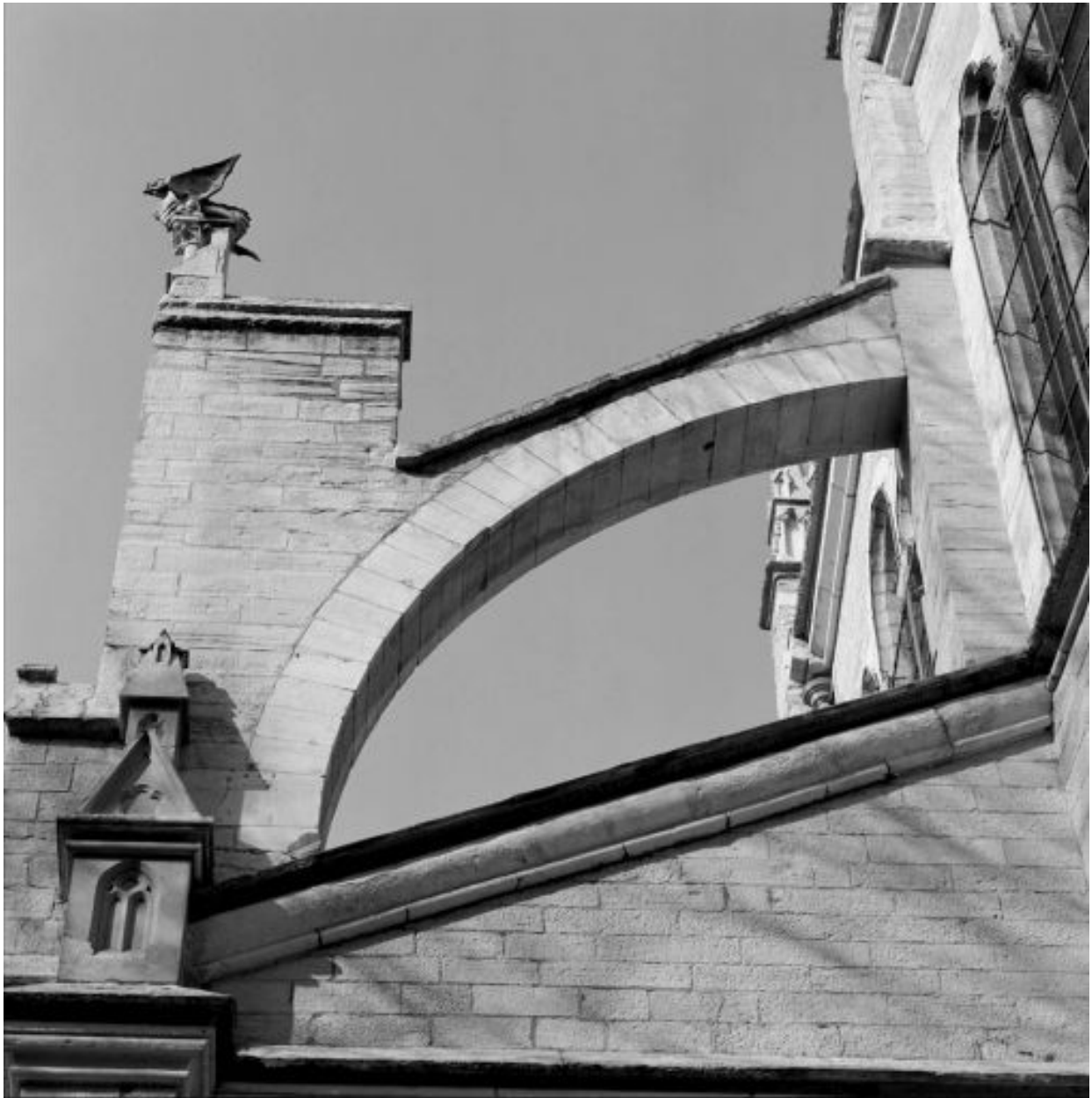
Elévation sud : détail d'un arc-boutant et d'une sculpture d'amortissement
