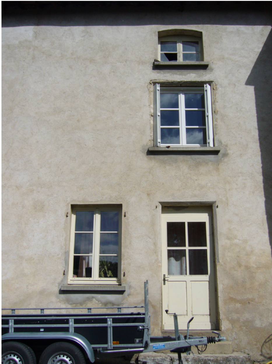
Détail de l'élévation principale : partie nord-est.
