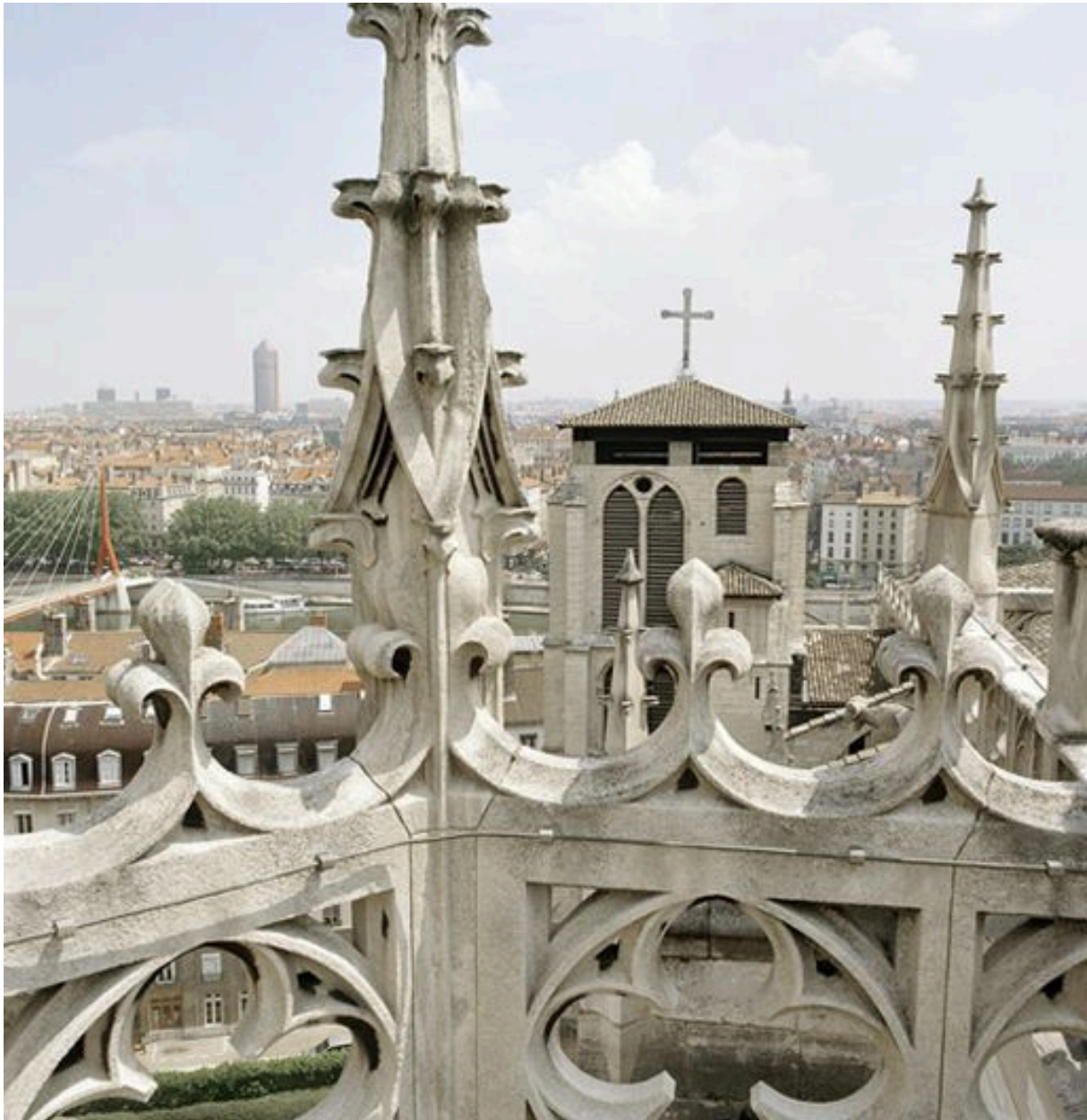
Vue depuis la toiture vers l'est
