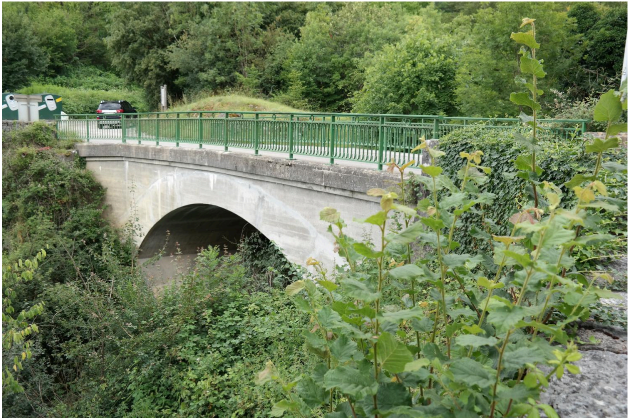
Pont Saint-André, vue de la face amont
