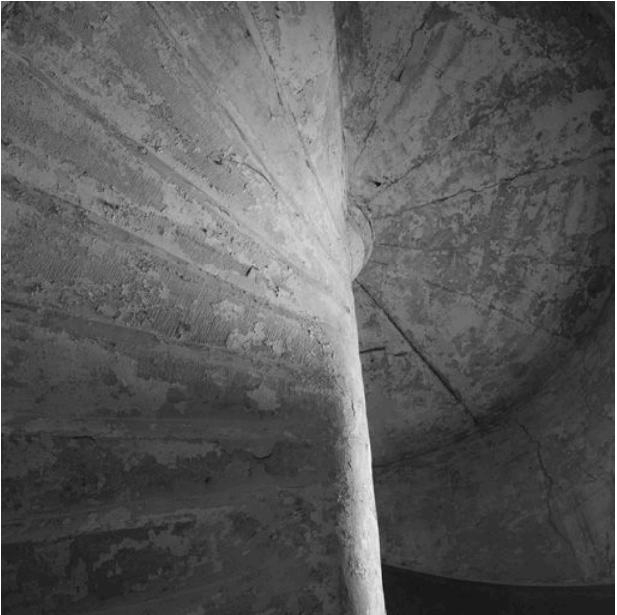
Corps de bâtiment ouest. Sommet de l'escalier principal
