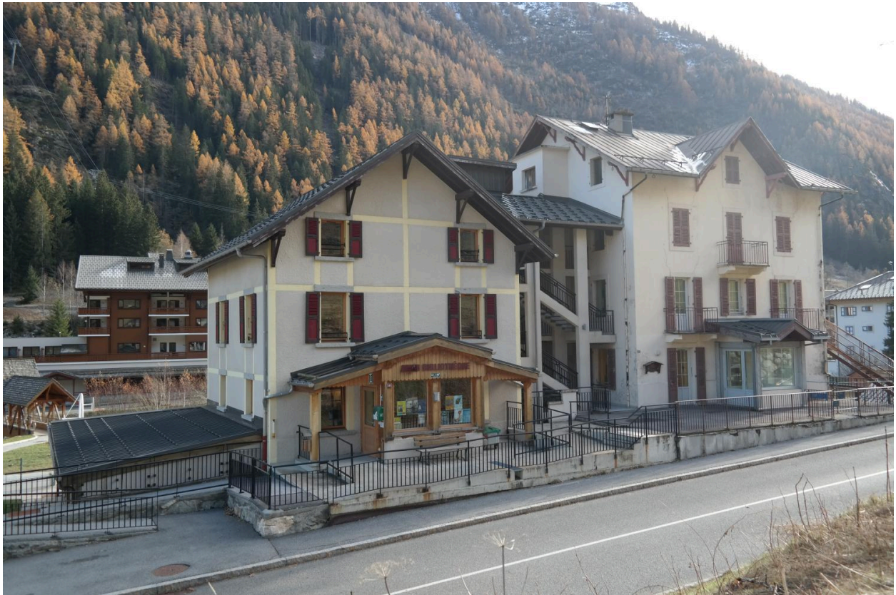
Vue de la façade principale de l'école et bibliothèque de Vallorcine
