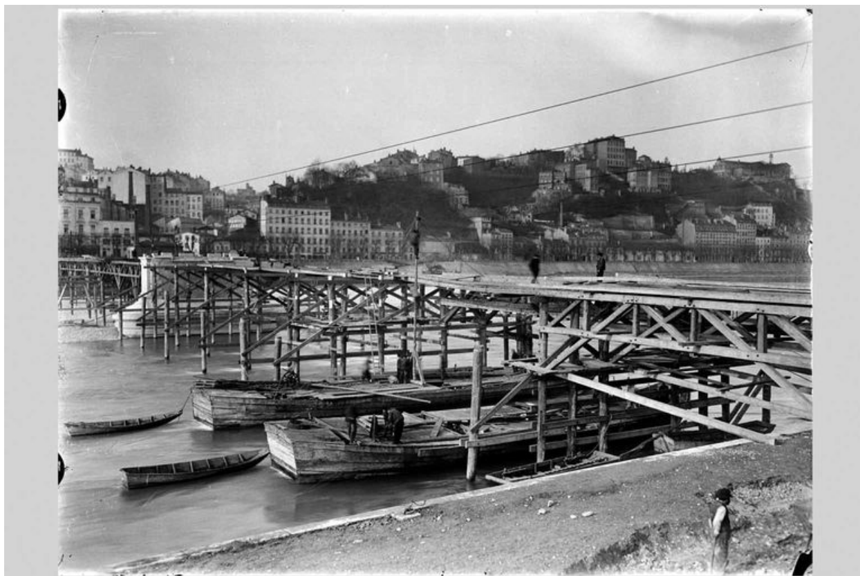
La construction du pont de la Boucle. Les premières structures du tablier. Photogr., [1902] (Arch. mun. Lyon. 15 Ph 1805)
