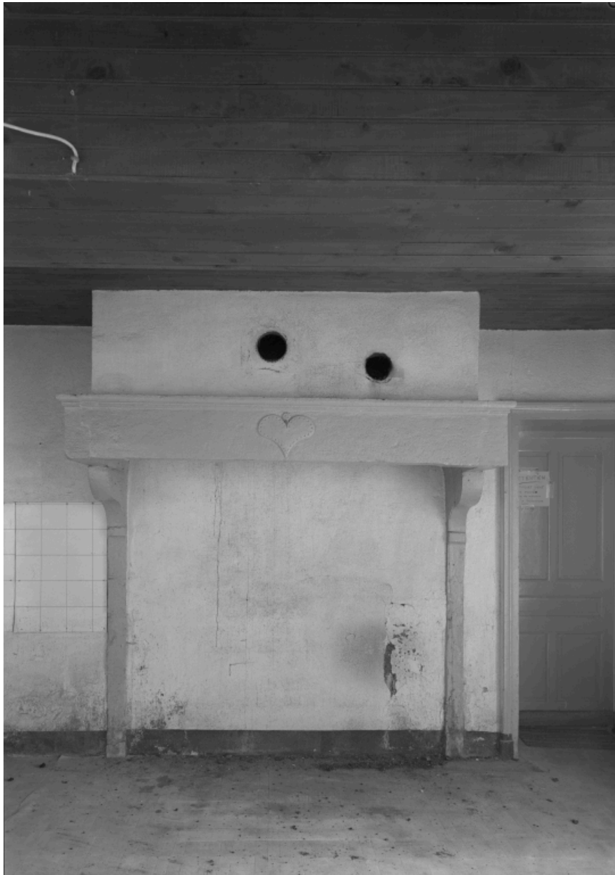
Cheminée de la cuisine.
