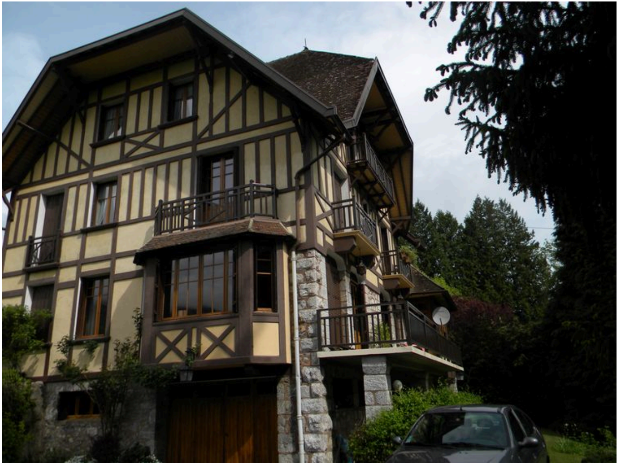
Vue de la façade sud.
