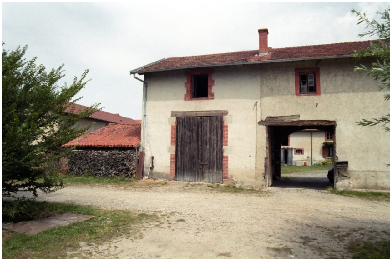
Vue partielle de la façade sud depuis le chemin.
