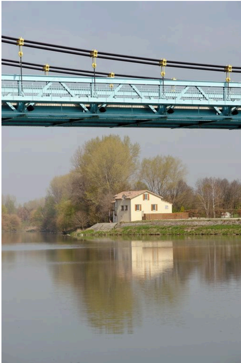
Vue partielle du tablier
