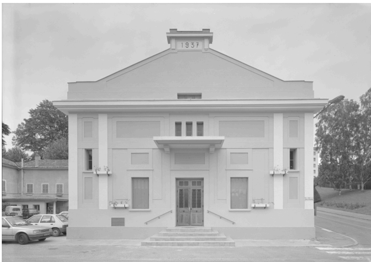
Salle des fêtes (ancien cuvage), façade.
