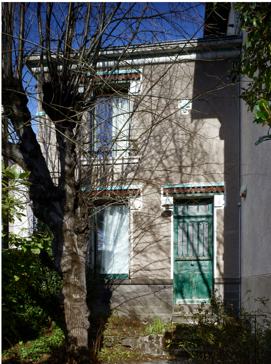
Elévation sud du bâtiment d'entrée
