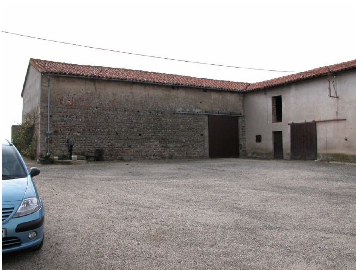
Angle sud-ouest de la ferme (caves et grange)
