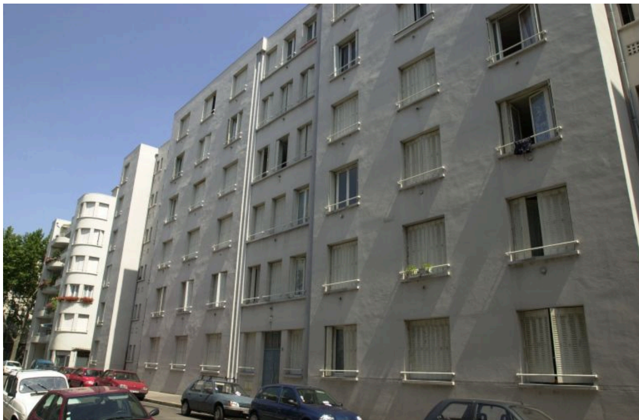
Elévation sur rue, 69 rue Delandine
