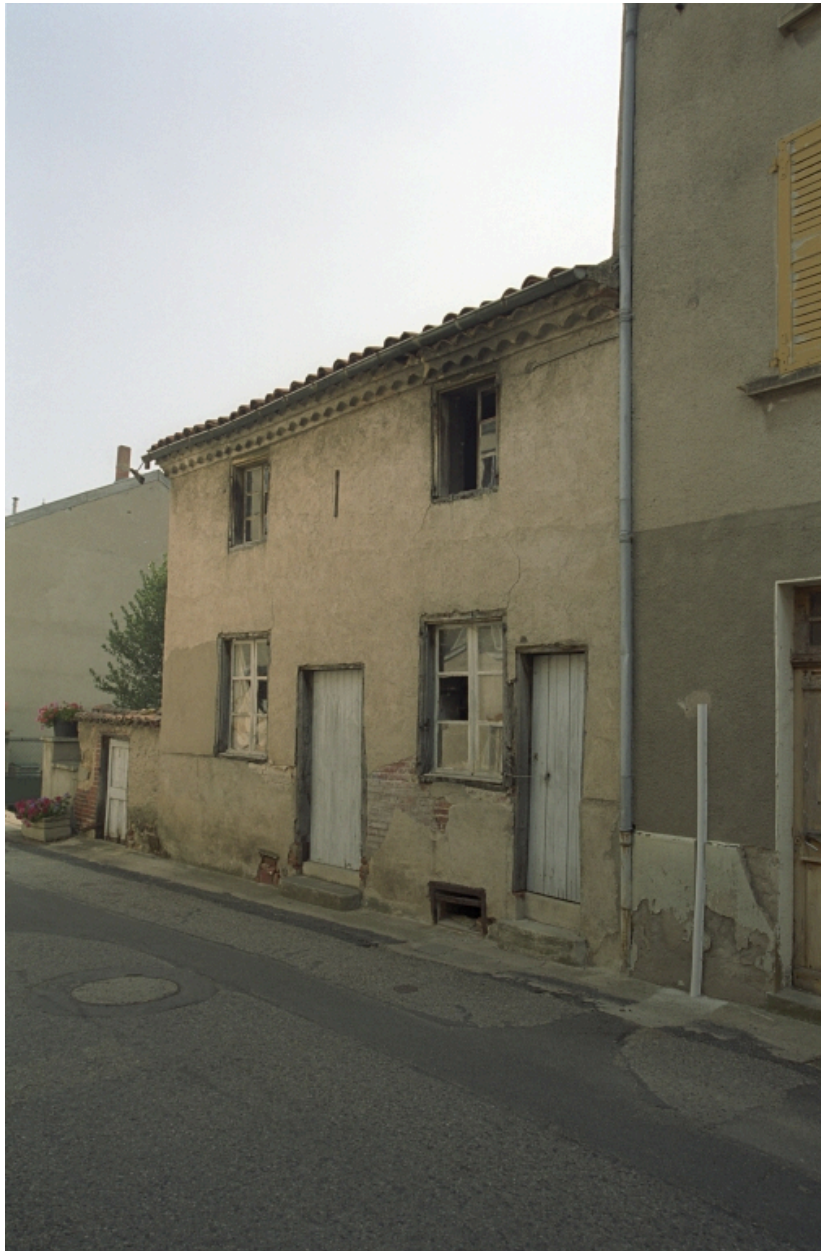
Maison de maréchal ferrant (A2 649), vue d'ensemble.
