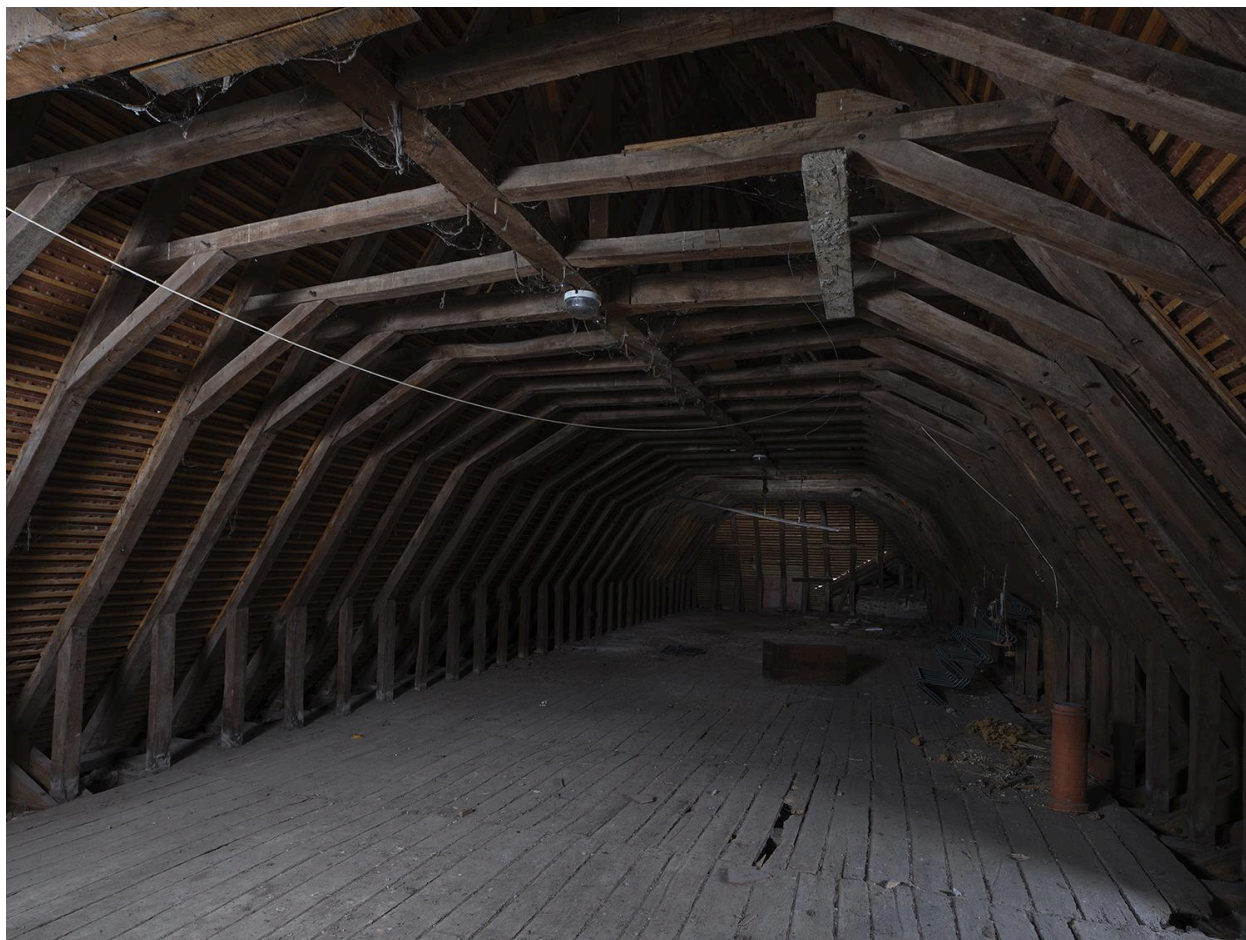
Comble : charpente de l'aile nord
