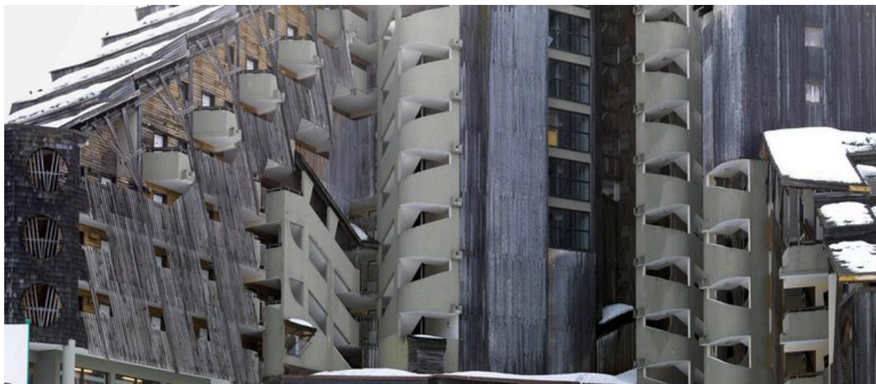
Détail de la façade nord-est
