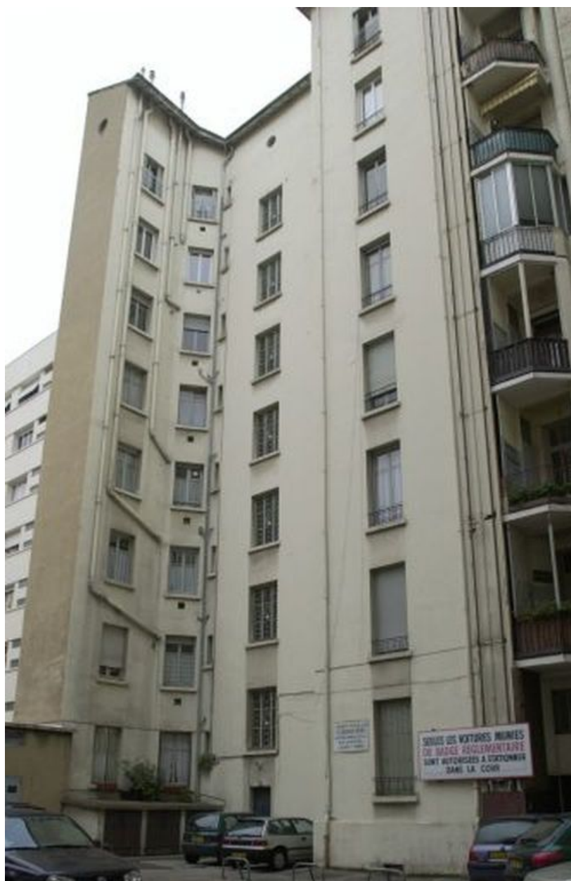
Vue générale de la façade postérieure
