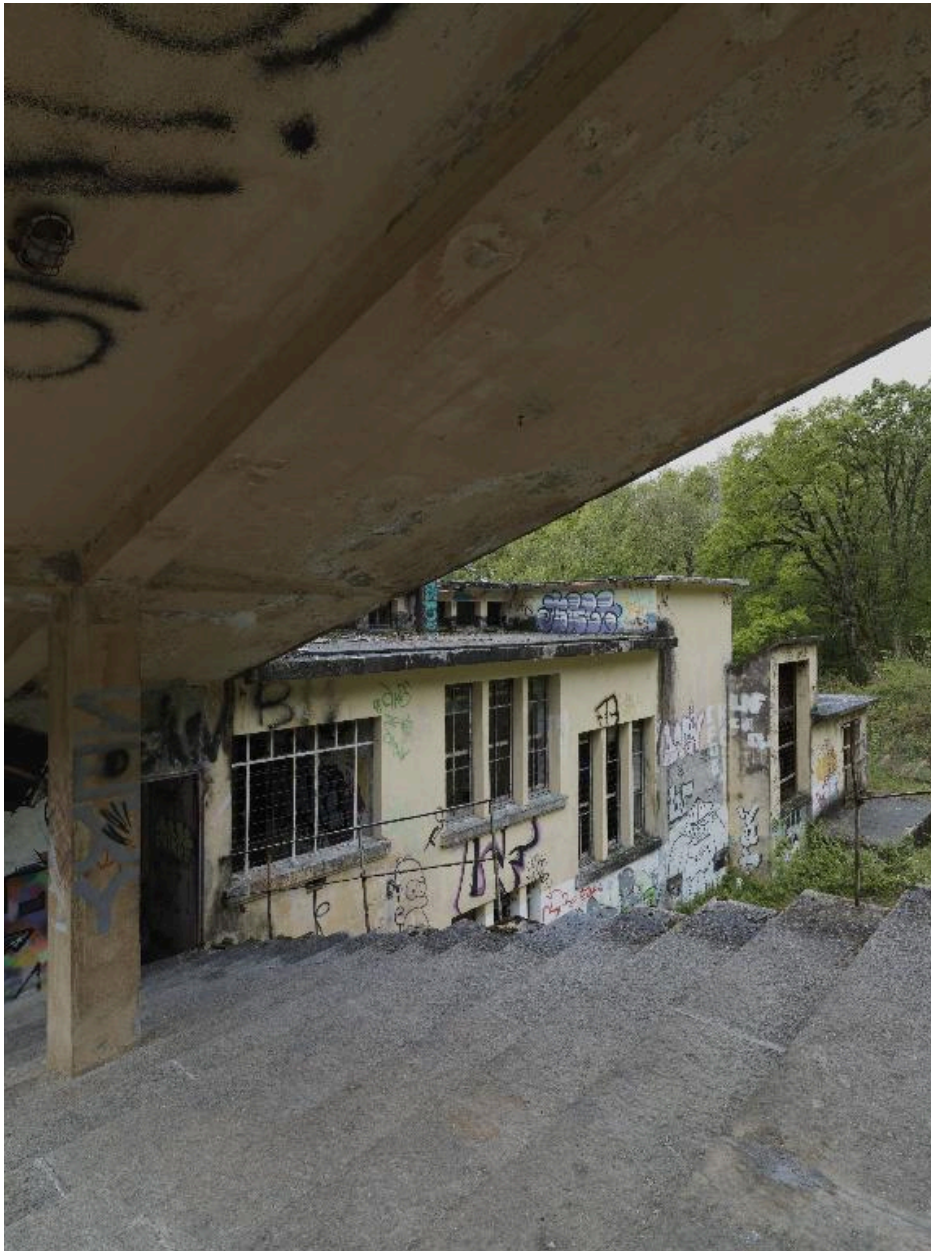
Escalier d'embarquement et détail de façade postérieure
