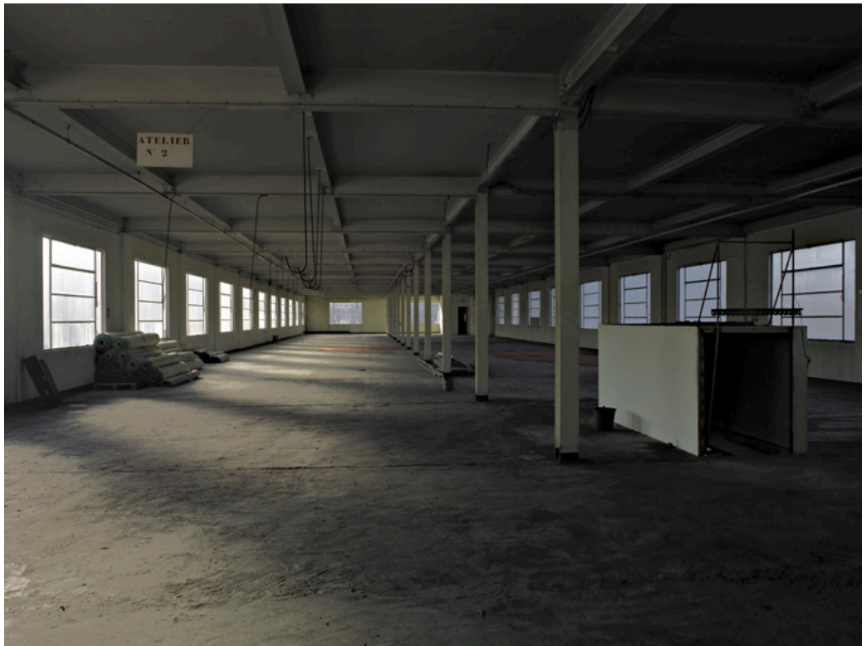
Vue d'ensemble d'un étage de l'aile nord de l'usine.
