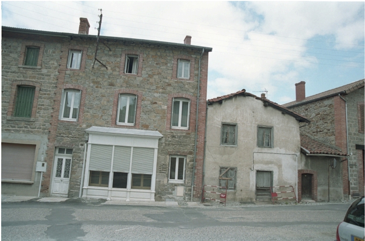
Au Bourg, maison et commerce (1986 C2 746). Vue d'ensemble de la façade principale.
