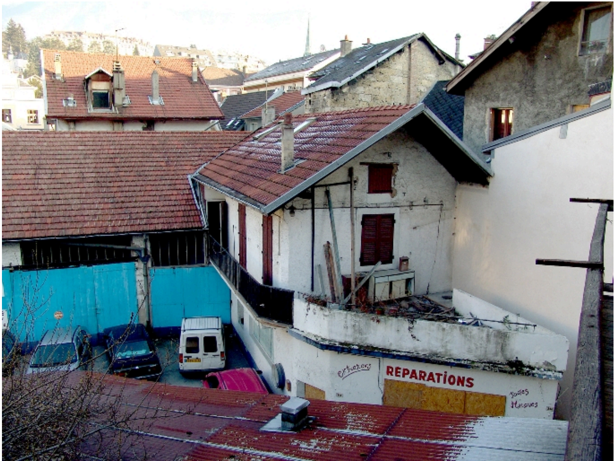
Garage de réparations automobiles : vue d'ensemble
