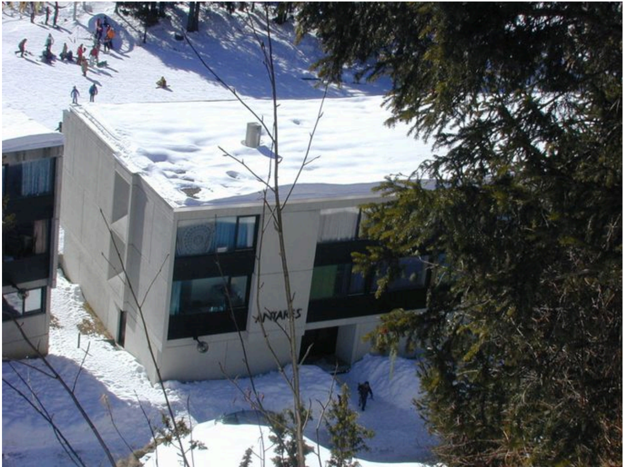
La résidence depuis le nord-nord-est. Le toit terrasse
