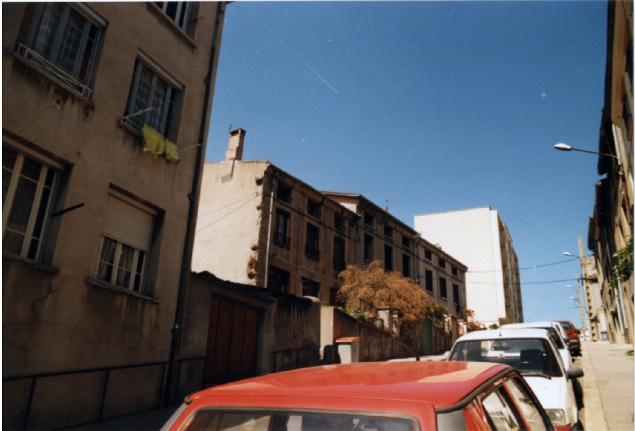
Vue d'ensemble depuis le sud-ouest. Etat en 1996
