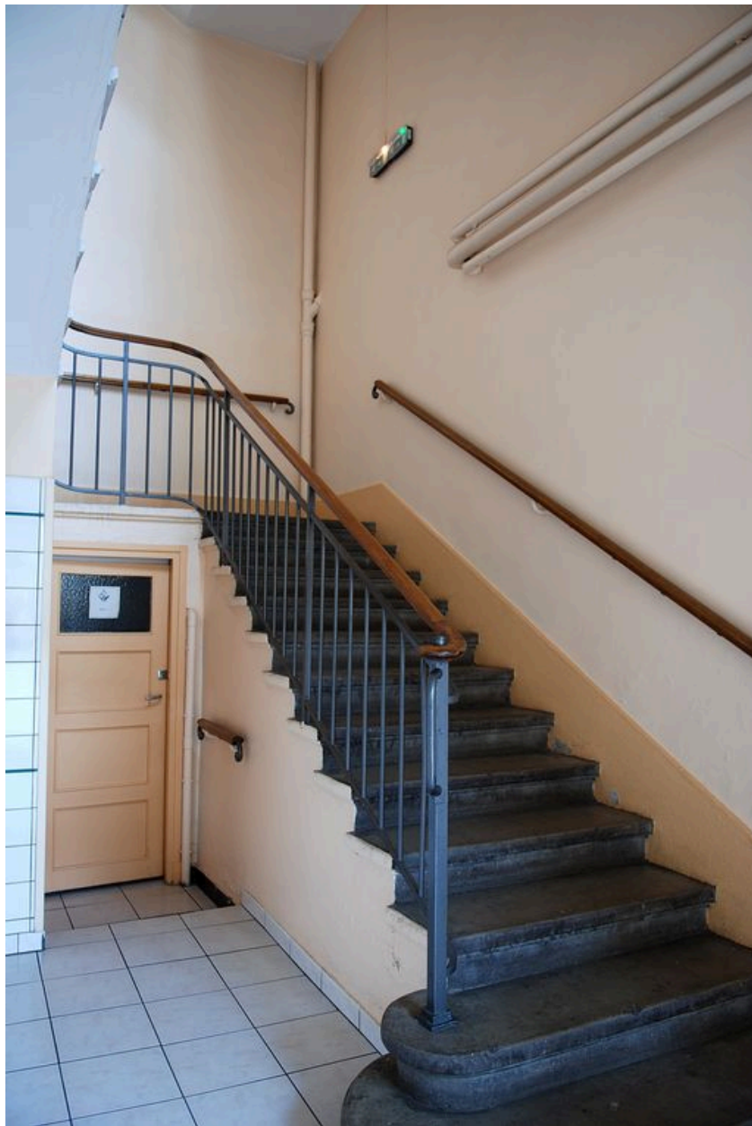
Corps de bâtiment principal : escalier sud-ouest
