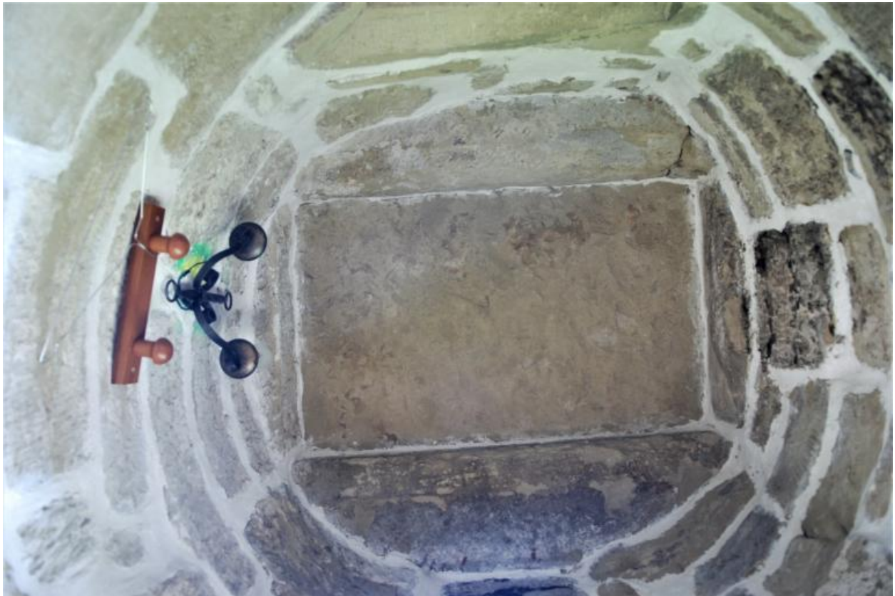
Etage de comble de la maison forte, tourelle d'angle sud, détail de la voûte plate.
