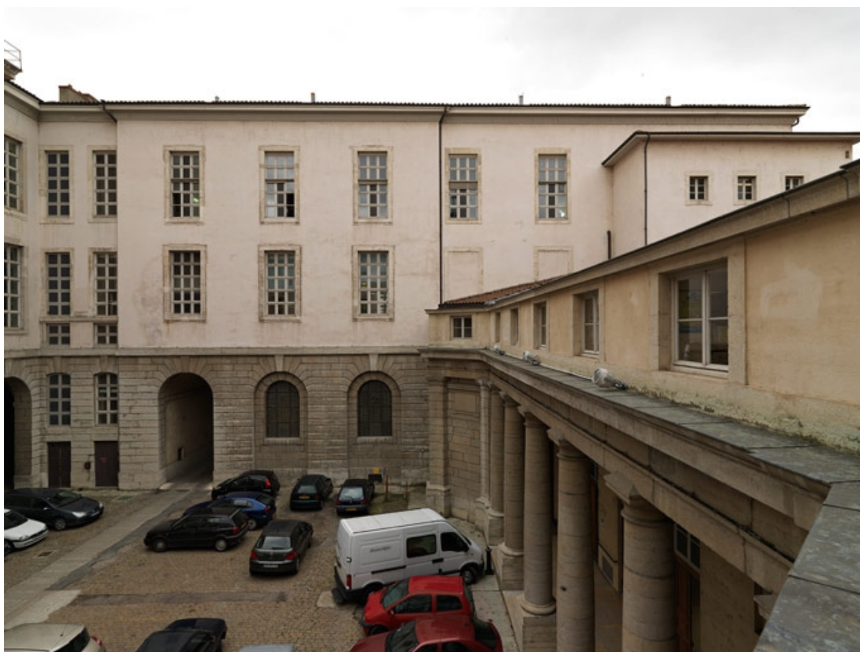
Bâtiment G. Façade nord sur la cour de la cuisine et retour du bâtiment I à droite
