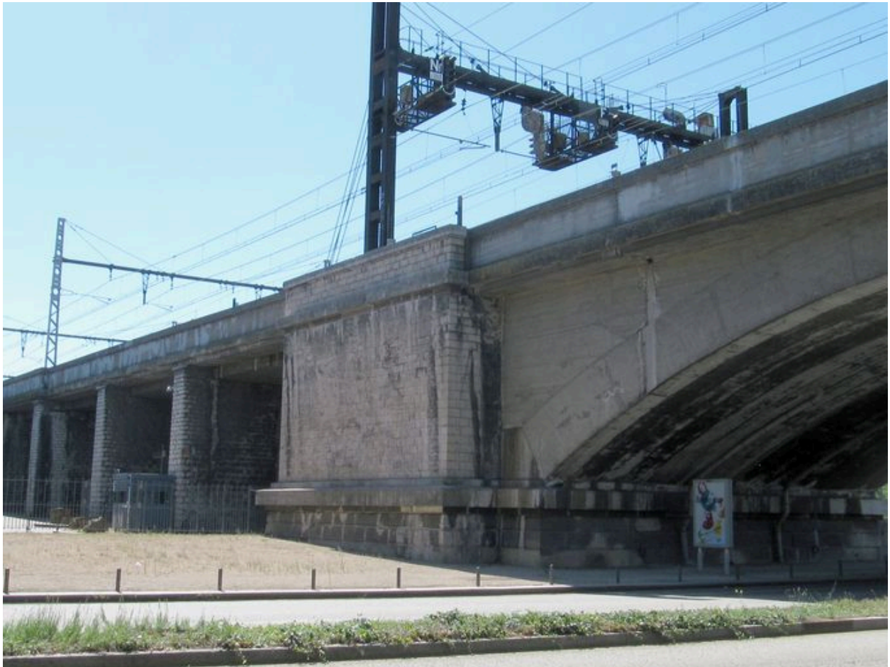
Vue partielle, culée gauche, face amont (depuis la rive gauche)
