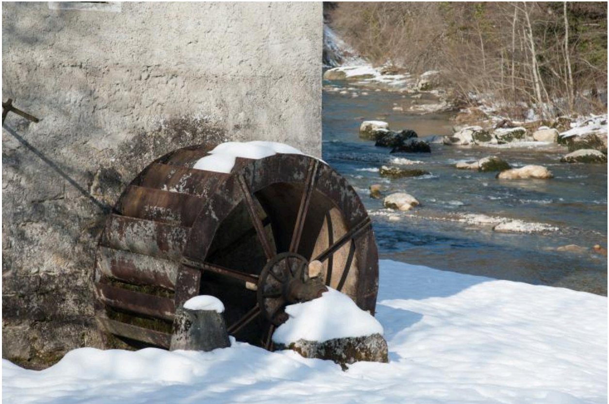
Bâtiment principal, soubassement de l'élévation est et roue du moulin.
