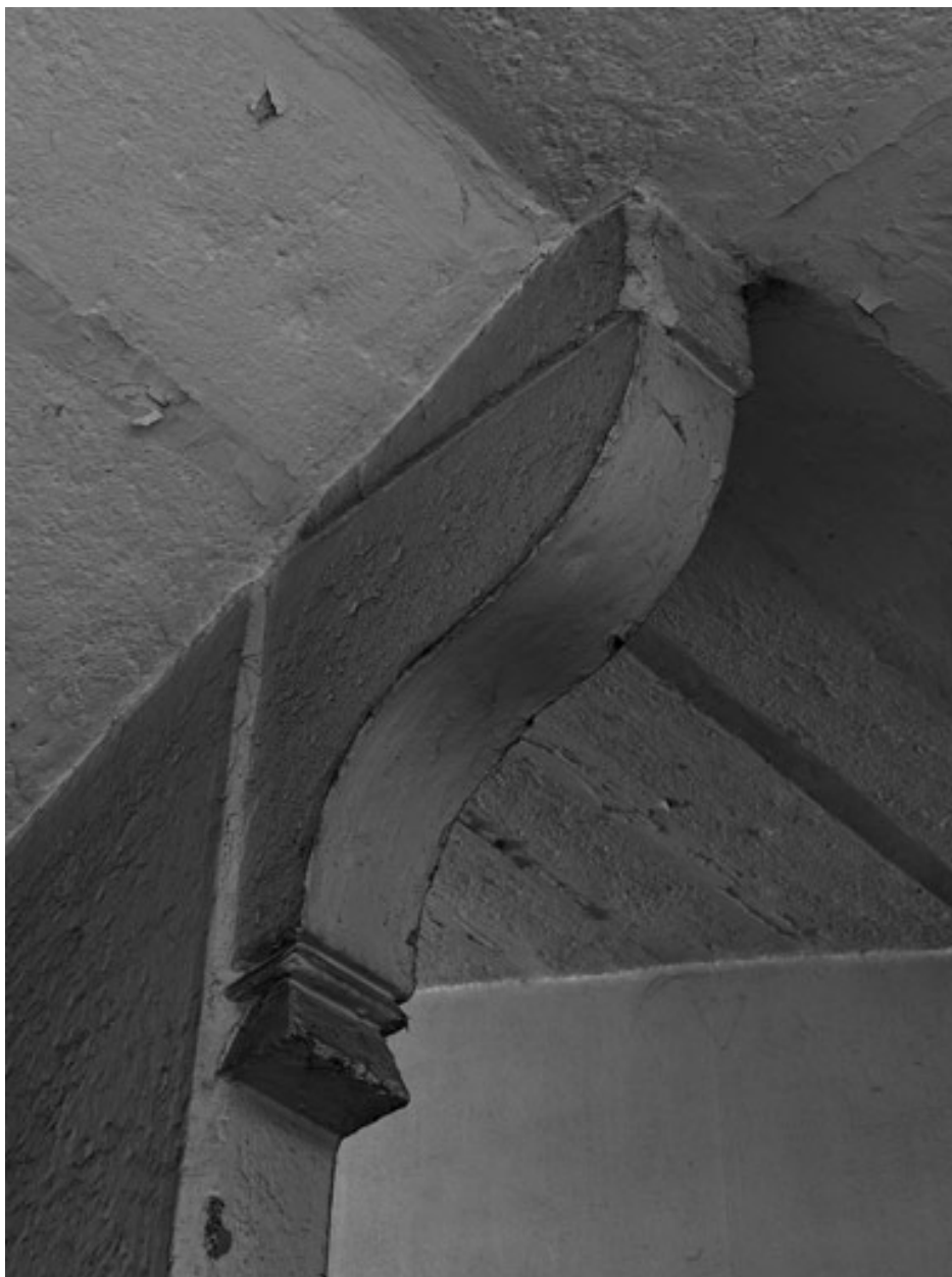
Bâtiment I. Console supportant le palier de l'escalier
