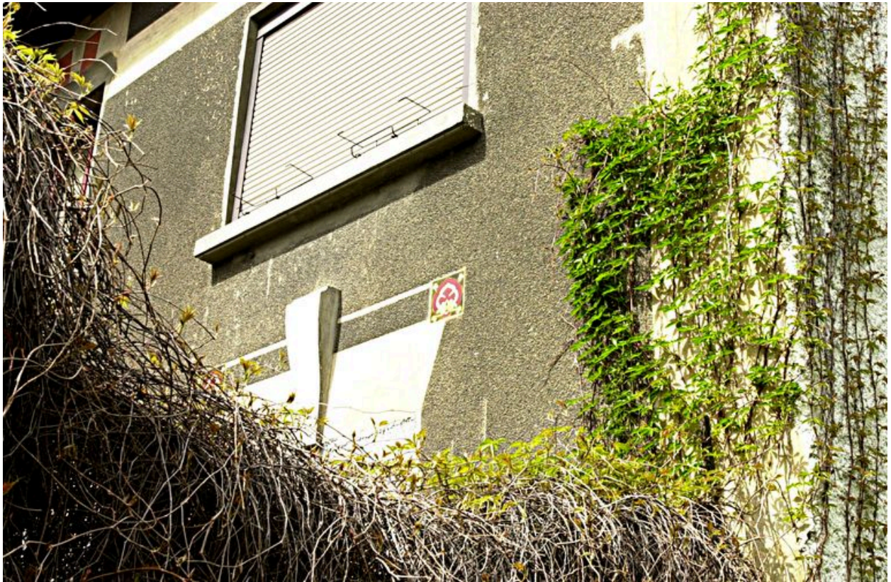
Façade principale, détail du décor
