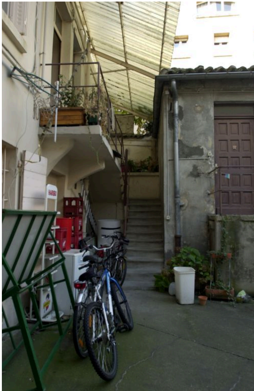
Vue de l'escalier extérieur d'accès à l'étage
