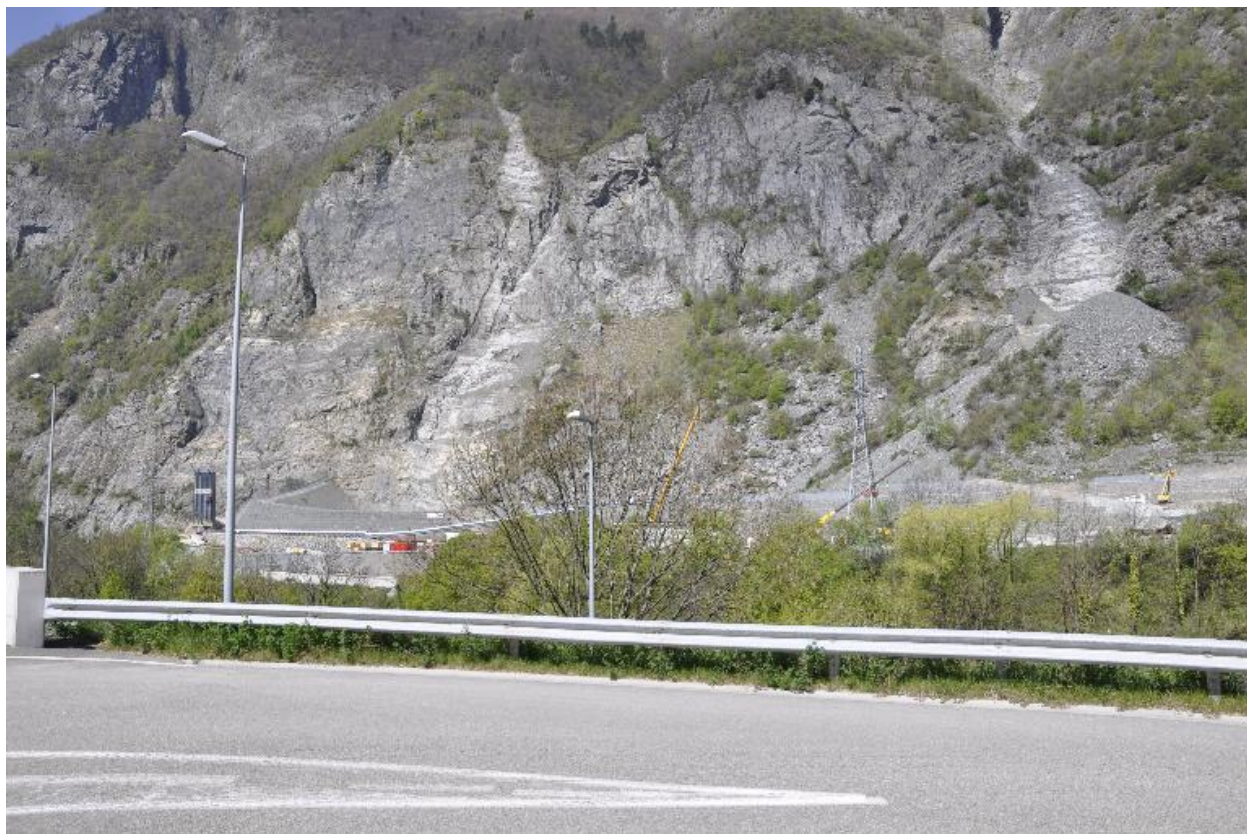
Vue de travaux de terrassement/carrière
